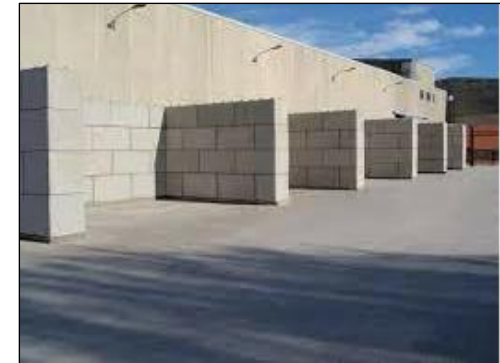
Box para almacenamiento modular con bloques de hormigón.
